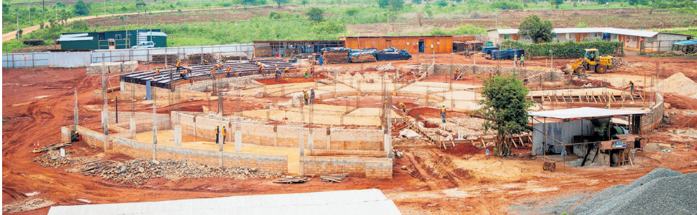
Maendeleo ya ujenzi wa jengo la taaluma la Chuo Kikuu Mzumbe (Kampasi Kuu) ambalo ujenzi wake unatekelezwa kupitia fedha za mradi wa HEET.
