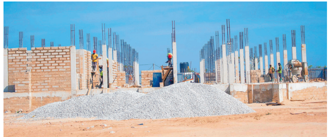
Maendeleo ya ujenzi wa mabweni ya wanafunzi wa Chuo Kikuu Mzumbe (Kampasi ya Tanga) ambayo ujenzi wake unatekelezwa kupitia fedha za mradi wa HEET.
